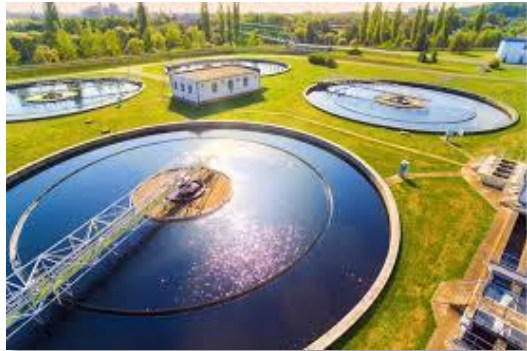
Trink- und Abwasser
